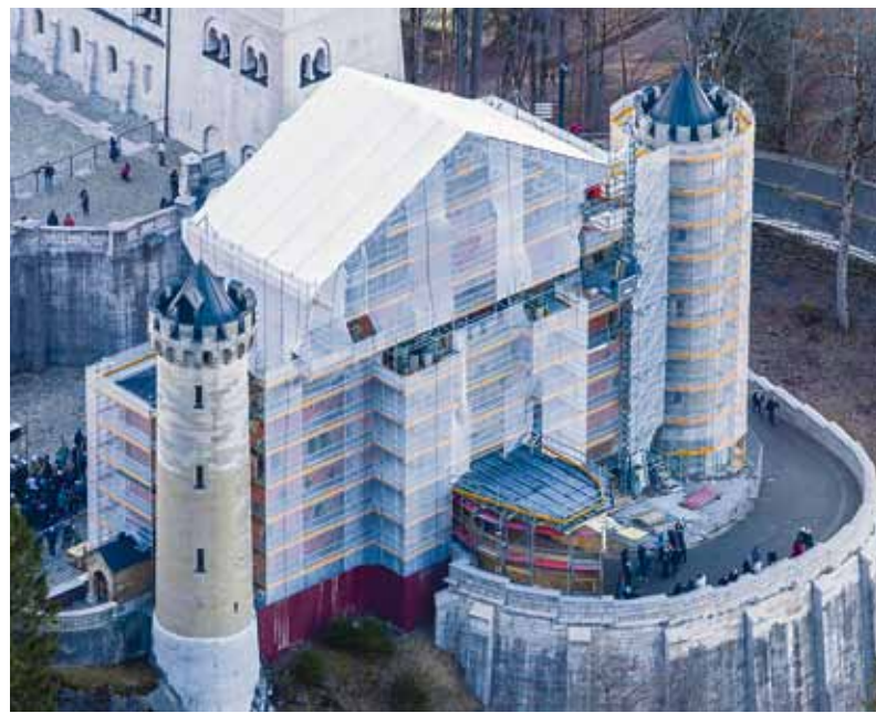
Die Spezialisten von BSB Bau- und Spezialgerüstbau Franke & Wagner GmbH greifen auch bei den aktuellen Arbeiten auf eine Transportbühne des bayerischen Herstellers Geda-Dechentreiter GmbH & Co. KG zurück – auf eine Geda 500 Z/ZP.
