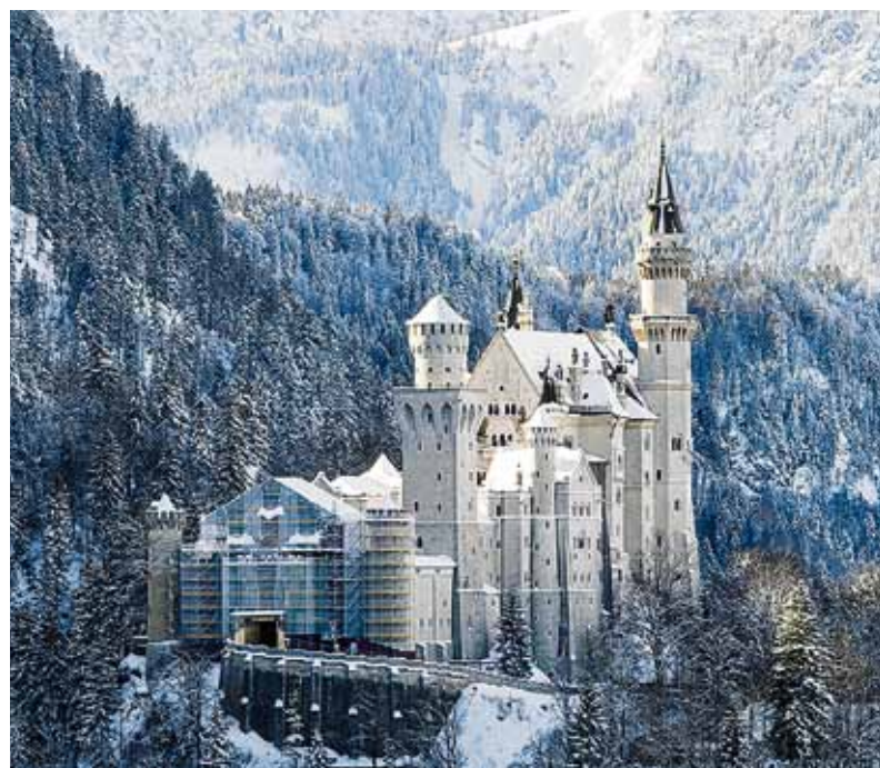
Die BSB Bau- und Spezialgerüstbau Franke & Wagner GmbH aus Schmöln errichtete bereits Anfang Oktober 2016 ein Arbeits- und Schutzgerüst mit dem „Peri Up Flex“-Modulgerüstsystem.
